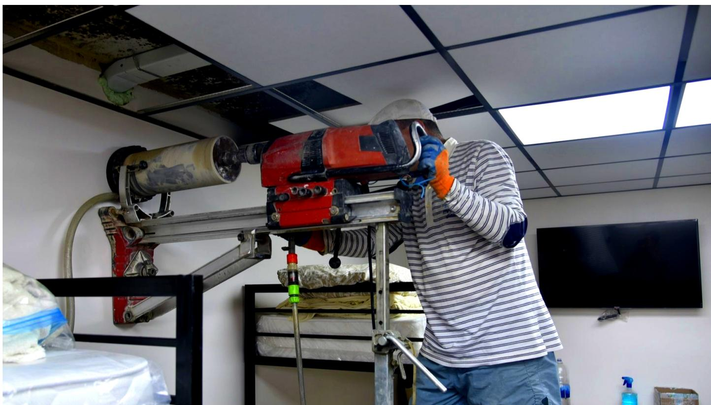
**In den zwei Schlafzimmern des St. Spyridon sorgt nun eine Lüftungsanlage für frische Luft und regelt die Luftfeuchtigkeit. Hier wird gerade der Schacht in die Kellermauer gebohrt.**
